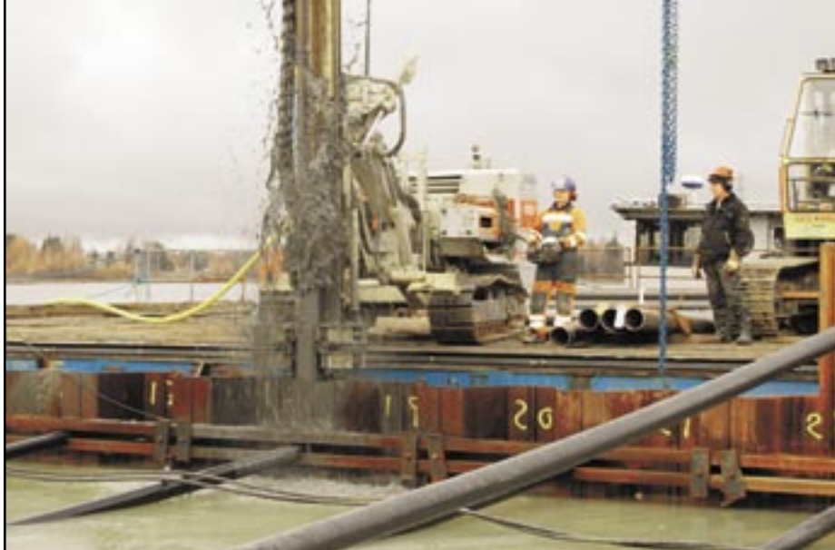
Ronny Edwardsson sköter borrhningen 15 meter under vattnet och Lars-Åke Lundgren ser till att arbetet flyter på.
